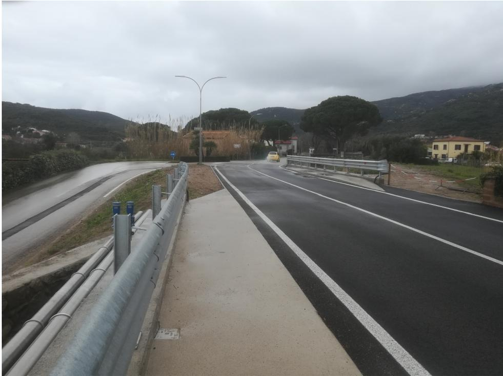
Il ponte è stato realizzato con uno scatolare in cemento armato, con spalle oblique rispetto al tracciato stradale, dello spessore di 40,0 cm, munito sui bordi di travi estradossate, sempre incastrate alle spalle. L'impalcato ha uno spessore di 30 cm al di sopra del quale è stato realizzato il pacchetto stradale. La fondazione dello spessore di 40,0 cm è costituita da una platea pressoché rettangolare.
